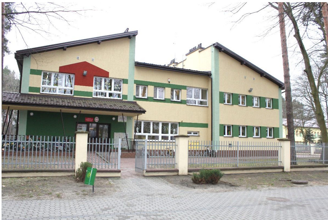
Fotografia 14 Budynek Zespołu Szkół z Oddziałami Integracyjnymi w Pustkowie-Osiedlu
