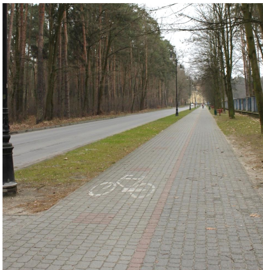
Fotografia 15 Chodnik dla pieszych ze ścieżką rowerową przy drodze osiedlowej (między drogą powiatową a Kompleksem Sportowo-Rekreacyjnym)
